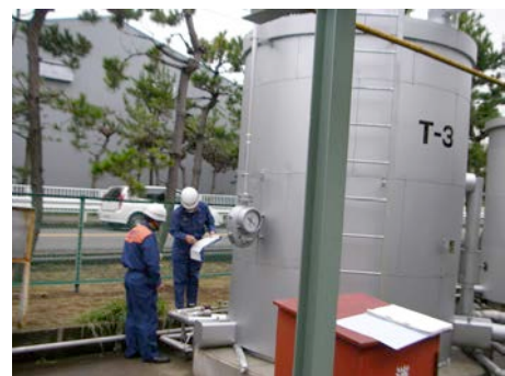
屋外タンク新設
