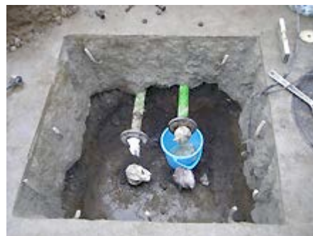
地下タンク立ち上がり管交換
