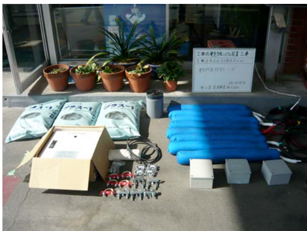
電気防食システム工事
