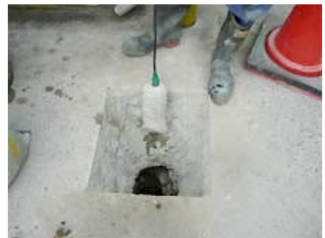
亜鉛合金電極埋設
