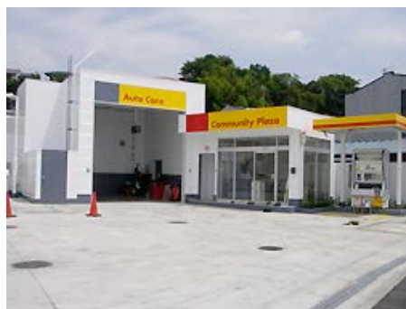
施工例：コンパクトに
