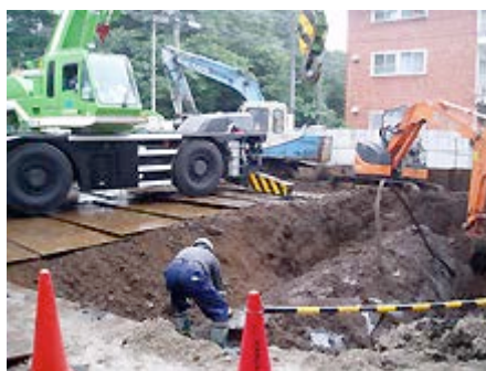
30KL 地下タンクの入替え
