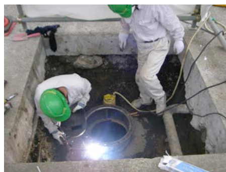
地下タンク開放工事
