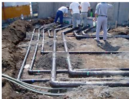
老朽化による油配管の交換
