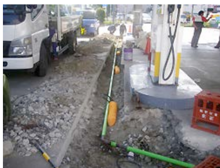
吸油管防触施工
