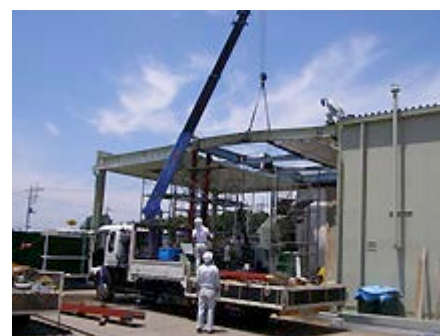
キャノピーの屋根掛け替え工事
