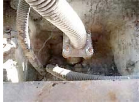
配管絶縁ボルトナット取付
